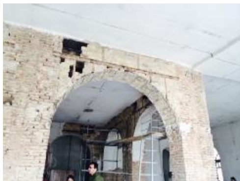
حذف پلاستر گچی از دیوارهای داخلی
