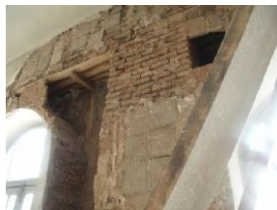
حذف پلاستر گچی از دیوارهای داخلی
