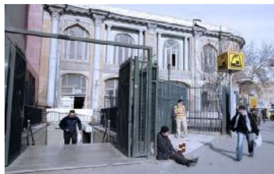
ورودی مترو در ضلع جنوبی ساختمان موزه صنعتی
