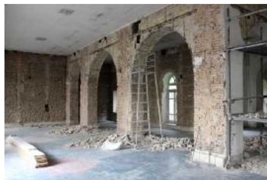
حذف پلاستر گچی از دیوارهای داخلی
