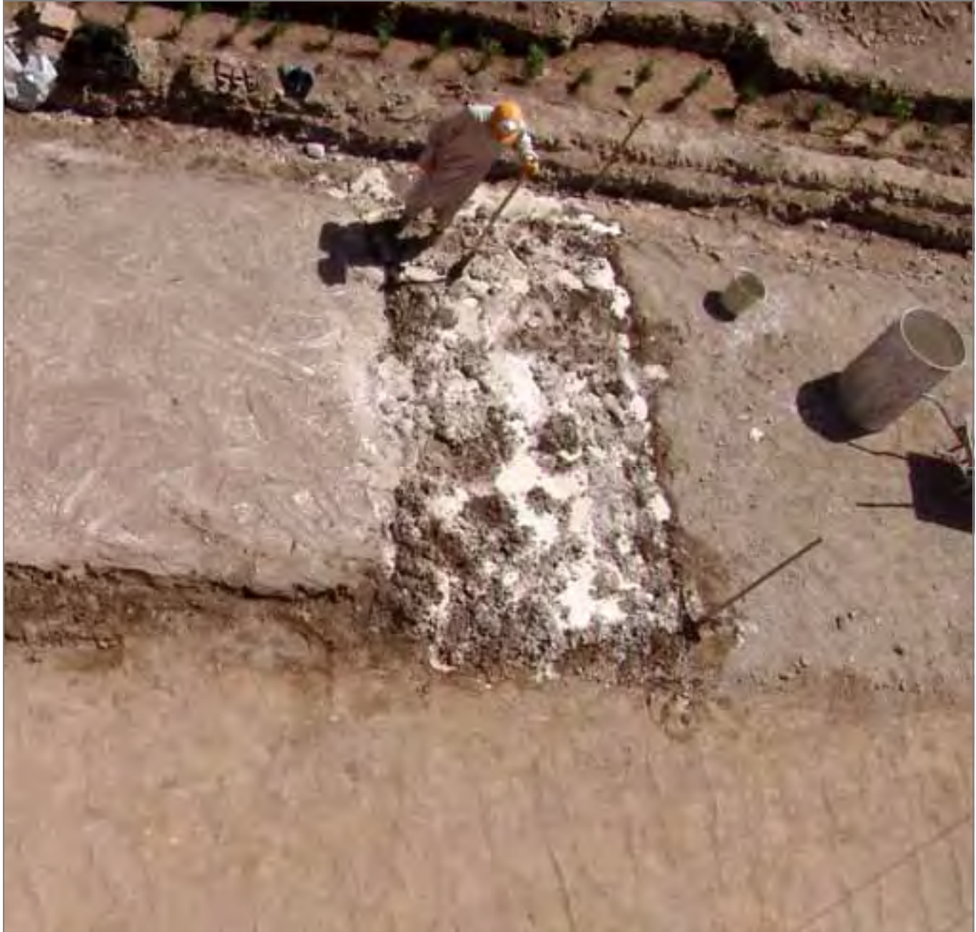
تصویر ۱۸۱ : ساخت شیفته بادوغاب آهک به منظور زیرسازی کف فرش محوطه.
