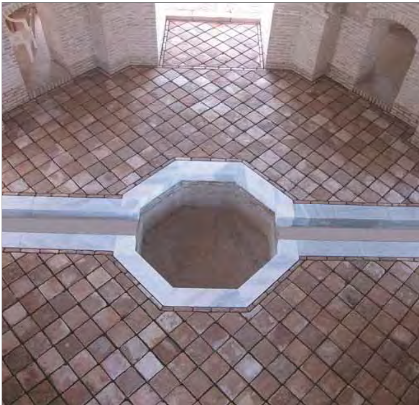
تصویر ۸۳ : کف فرش آجری، به شیوه کلاغ پر پیش از بندکشی، فضای مرکزی عمارت نمکدان، گازرگاه، هرات، افغانستان.
