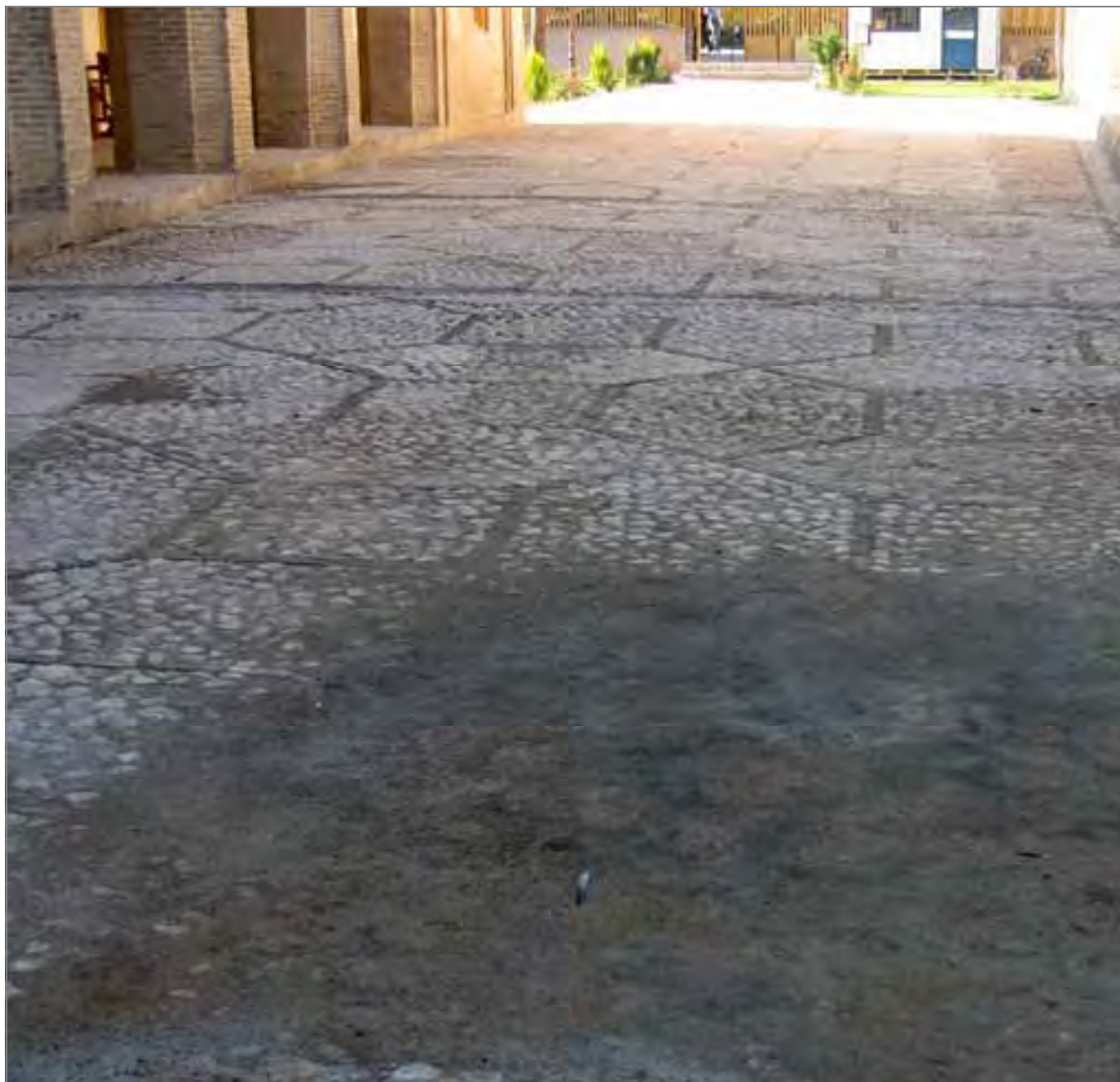
تصویر ۲۳۰: دورنمای حیاط سنگفرش و بخش آسیب دیده آن در اثر بی احتیاطی و ساخت ملات بر روی آن.
