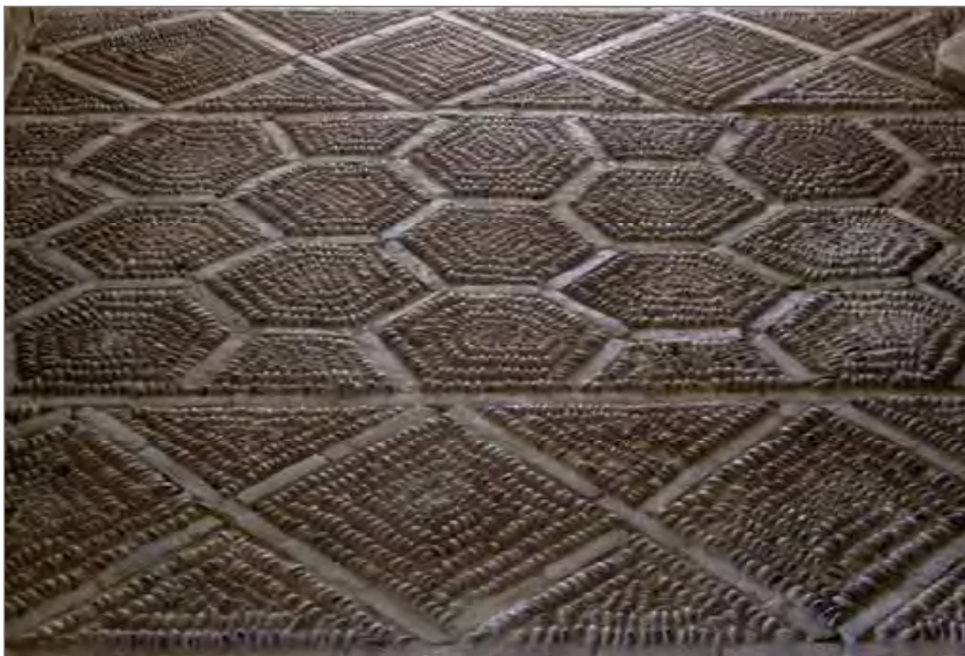
تصویر ۵۰: سنگفرش آژیانه، خانه مستوفی، شوشتر. در اصطلاح محلی به این گونه کفسازی ریگفرش گفته می شود.
