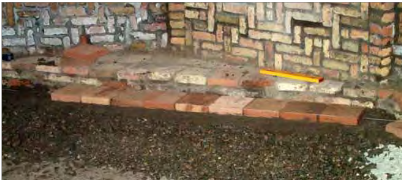
تصویر ۲۰۵: اجرای یک ردیف آجر در پای دیوار به عنوان لبهٔ کفسازی و «دلیل» برای تعریفِ صحیحِ حدود و ترازِ کفسازی.
