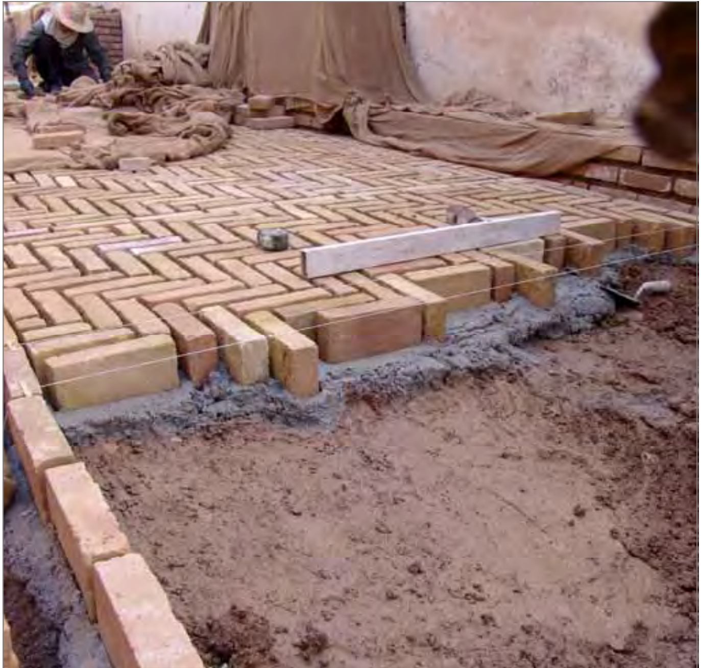
تصویر ۱۹۴: اجرای کف فرش آجری با آجر نیمه به صورت خَرند. همزمان دو ریسمان برای کنترل سطح آجر فرش نسبت به دلیل دور کشیده شده است.
