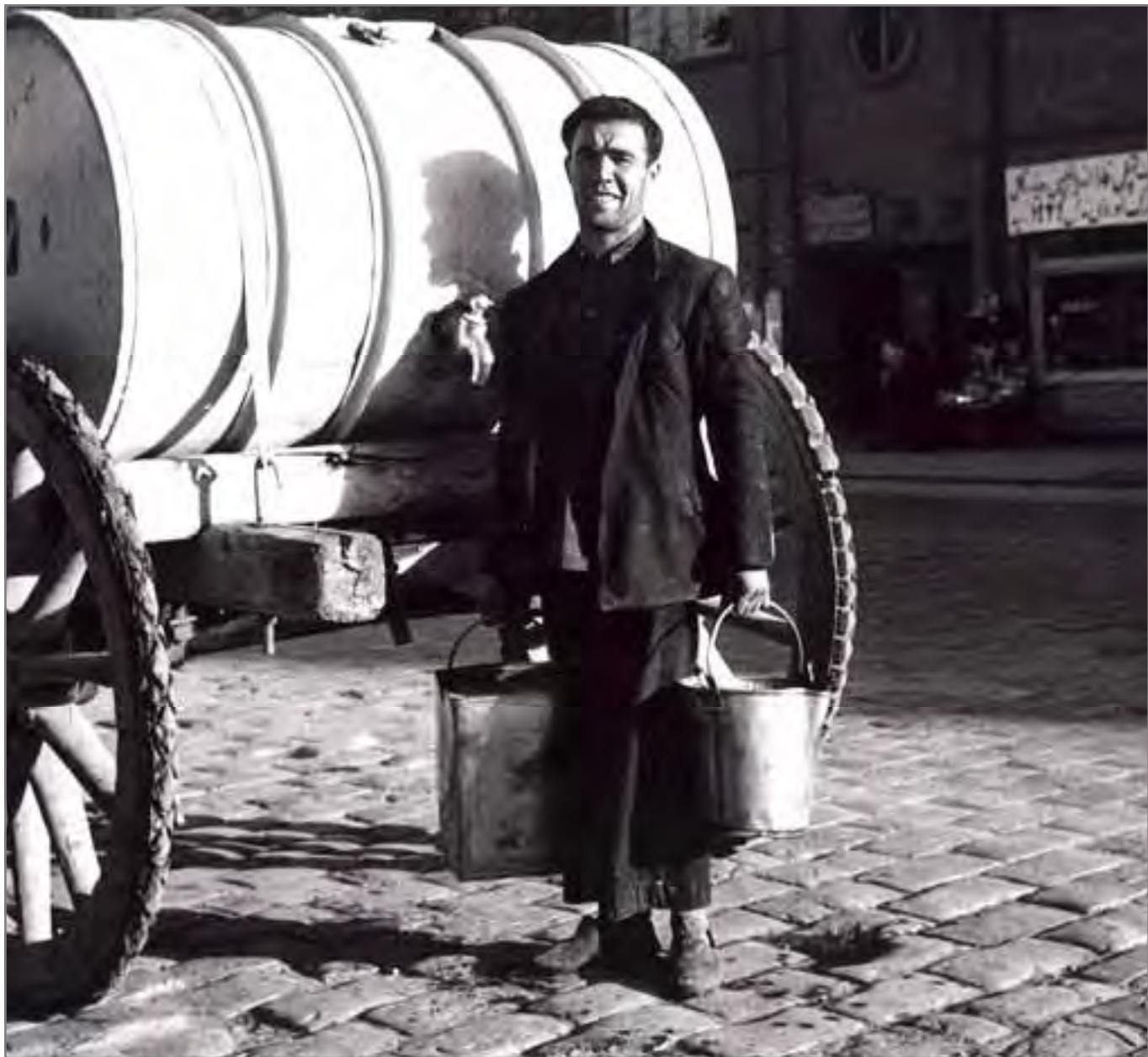
تصویر ۲۲: سنگفرش یکی از معابر تهران در دوره پهلوی اول (۱۳۰۴-۱۳۲۰ ه.ش.). کفسازی با سنگ‌های قواره ریشه‌دار مستطیلی و کاملاً هندسی اجرا شده است. همانطور که مشاهده می‌شود برای عبور عابر و گاری بسیار مناسب است. عکس: واهان تراپانجیان
