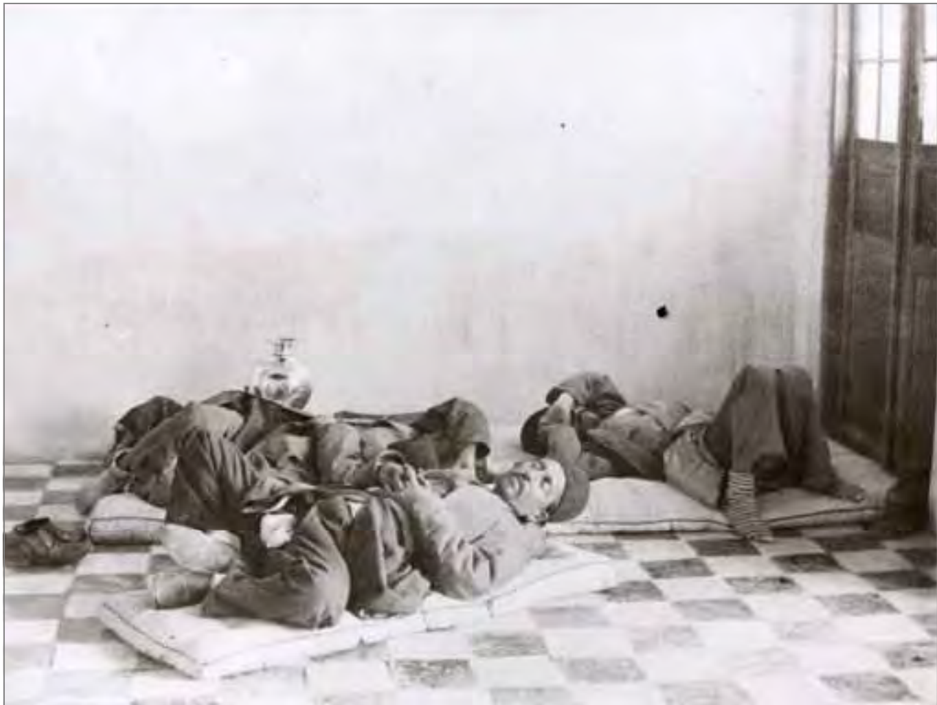
تصویر ۱۶۲: کفسازی کاشی، طرح شطرنجی، اتاق عمل‌جات کاخ صاحبقرانیه، ۱۳۱۲ق. منبع: آلبوم‌خانه کاخ گلستان
