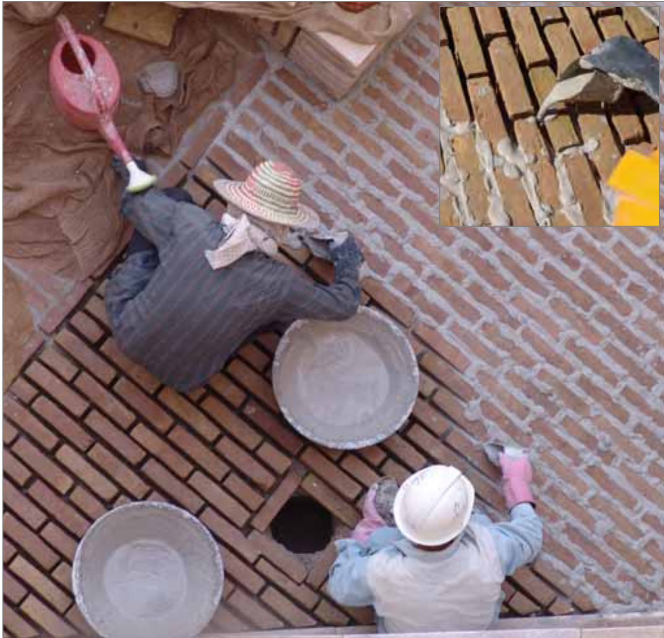
تصویر ۲۰۳: ریختن ملاتِ بندکشی در بندهای کفسازی آجری، خرنده(هره چین).
