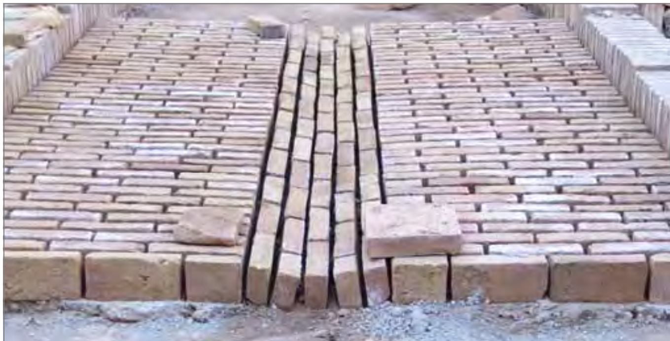
تصویر ۲۱۷: آبراه ایجاد شده در میانه راه آجرفرش، این آبراه کم عمق فقط برای هدایت نزولات جوی است که بر روی این سطح می‌بارد.
