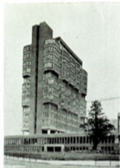
ساختمان اداره استانداری ایلسوری شهر بوکینک هامشیر اسکات ساختمان بتنی است .
