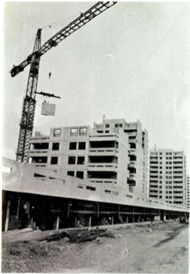
قسمتهائی از پرفایریکه در حال نصب
