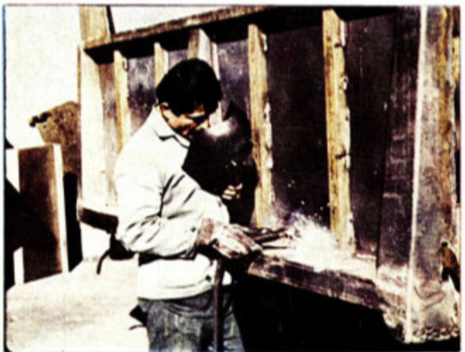
جوشکاری روی بدنه کلسیون سنگین
