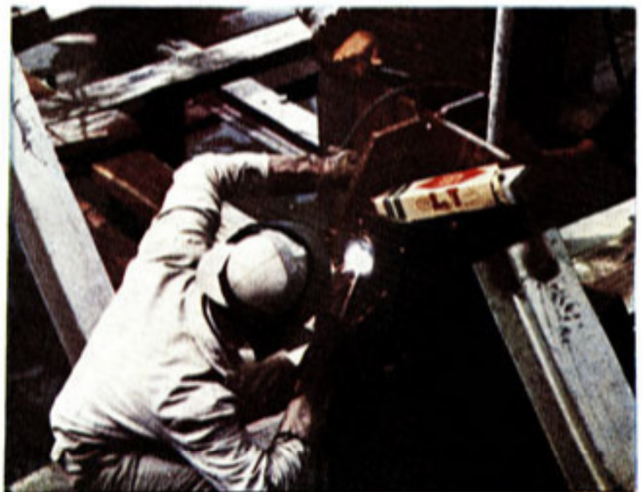
جوشکاری در اسکله سازی
