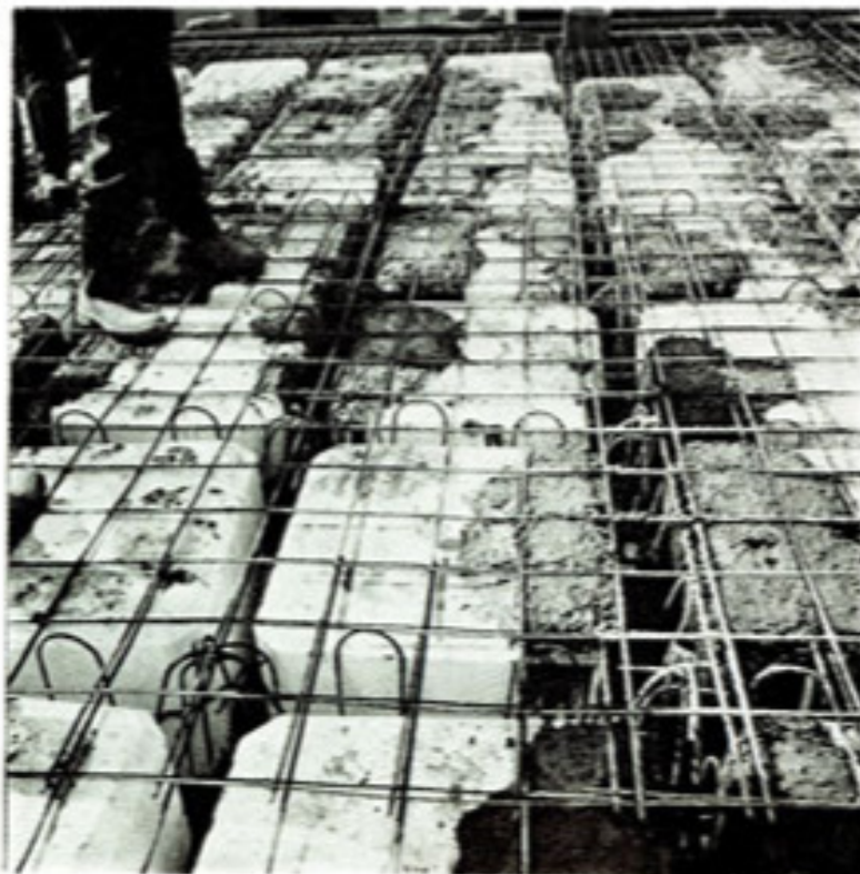
↑ نصب صفحات استروربور در سقف سردخانه‌ها
