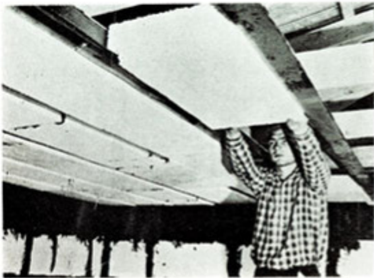
↑ نصب صفحات استروربور در سقف سردخانه‌ها
