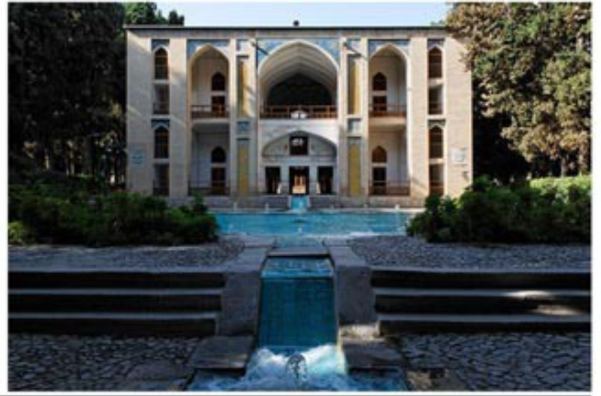
تصویر شماره ۳ : ارتباط آب با باغ فین کاشان
