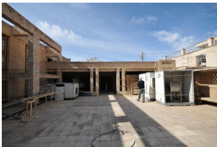
حیاط فرهنگی در حال احداث
