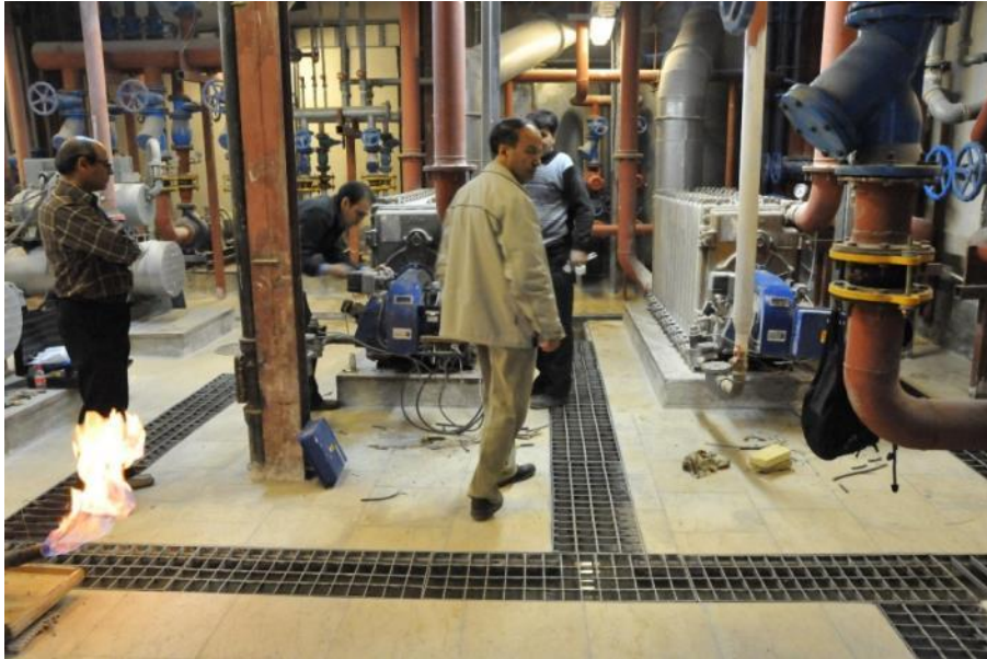
موتورخانه در حیاط خدمات و تجهیز آن
