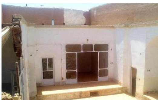
اغلب خانه‌های تخریب شده در این بخش، فاقد ارزش تاریخی و فرسوده است
