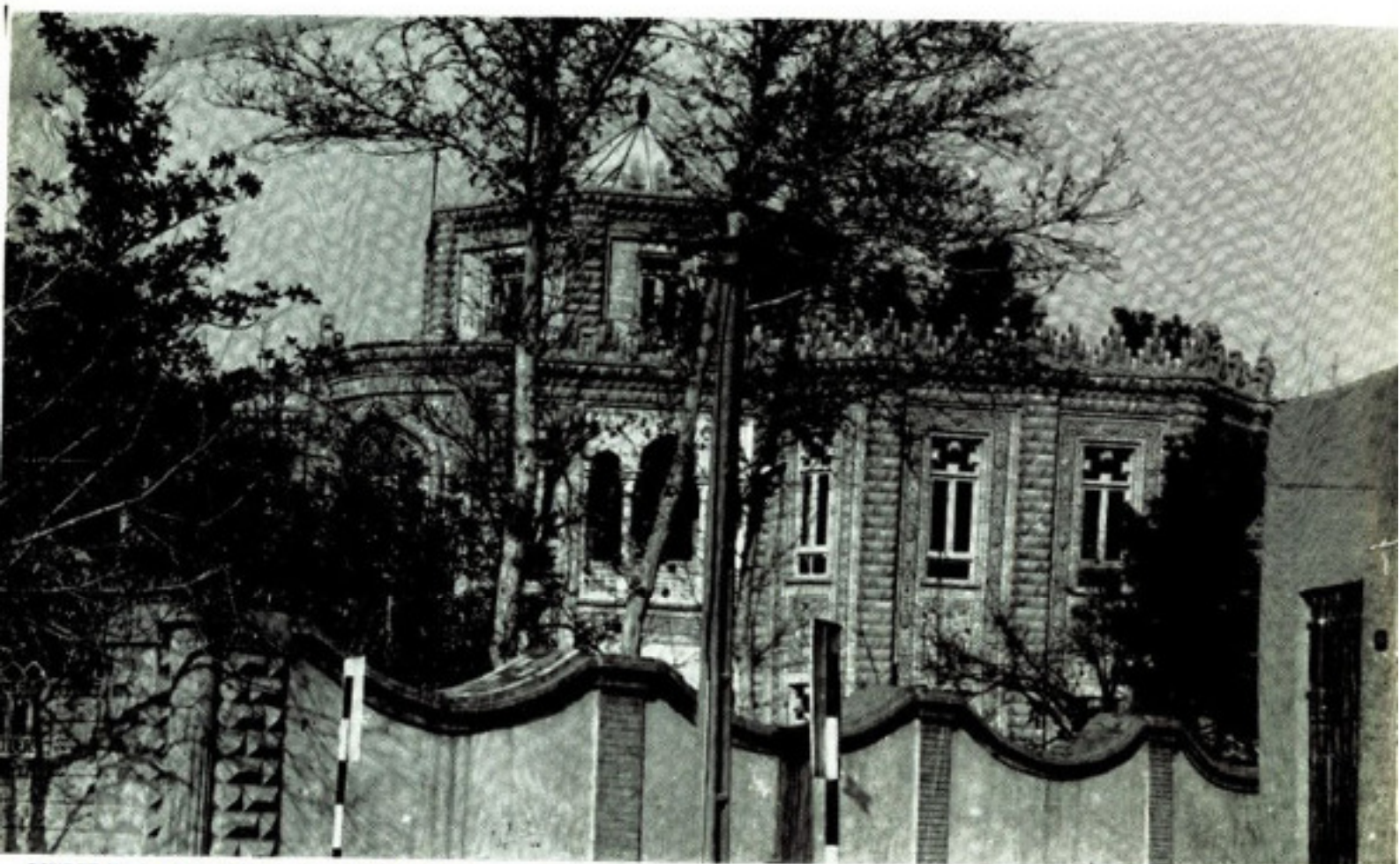
VIEILLE MAISON A TEHERAN EN CIMENT ET CERAMIQUE
