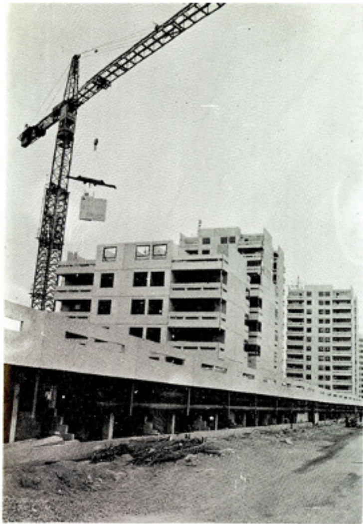
قسمتهائی از پرفایریکه در حال نصب
